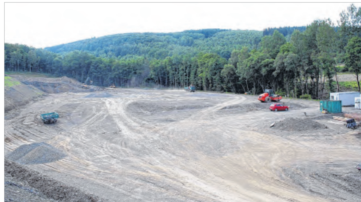
Mit einem speziellen Verfahren ist diese riesige Fläche verdichtet worden. Hier wird nächstes Jahr eine neue Produktionshalle der Fa. Thomas Magnete entstehen.
