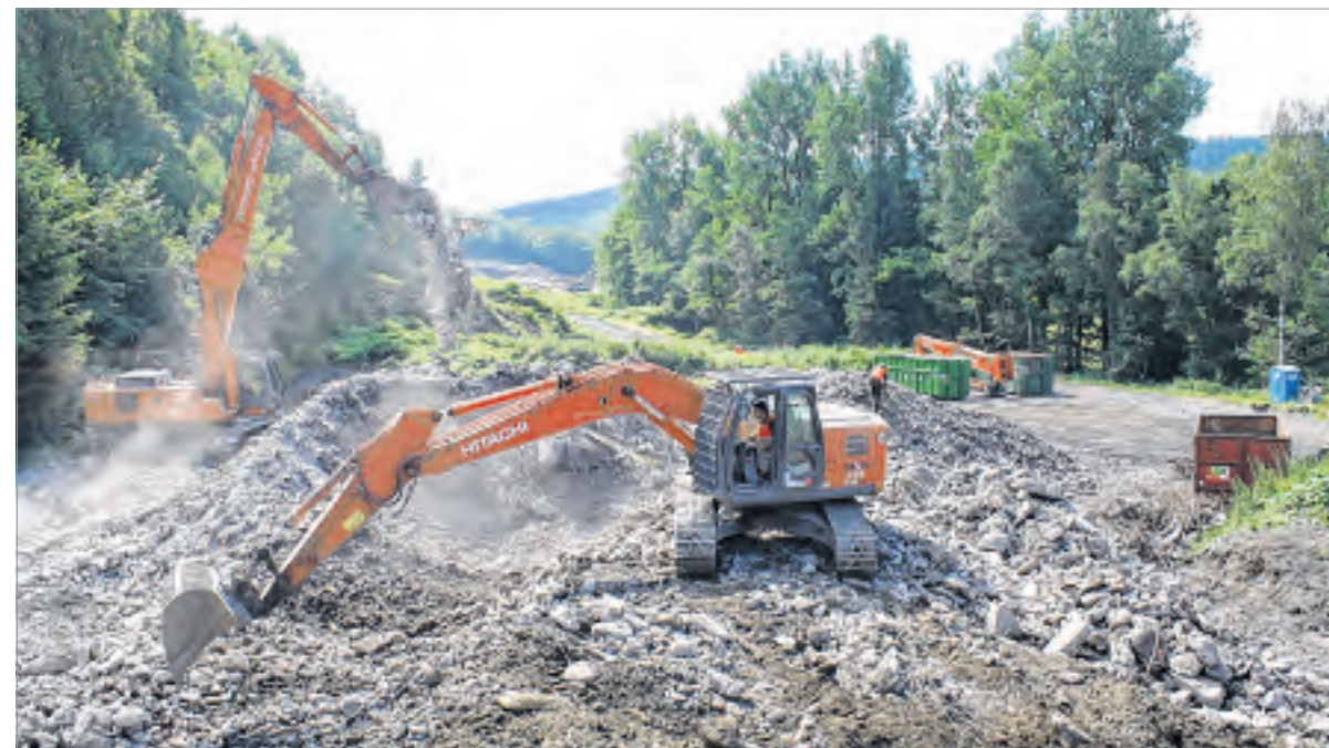
Nur noch ein riesiger Berg Schutt ist von der ehemaligen Erzaufbereitung übrig geblieben. Das Material wird nun geschreddert und beim Straßenbau vor Ort eine neue Verwendung finden.
