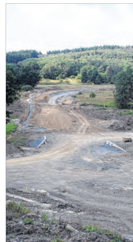
Die Trasse für die neue Straße hat bereits ihren Weg hinunter ins Tal gefunden. Allerdings werden Anschüttungen noch für ein verändertes Profil sorgen, schließlich ist hier kein Schanzentisch geplant.
