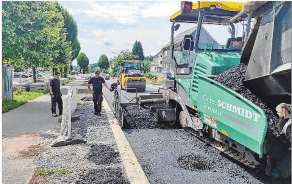
Rund 1000 Tonnen Tragschicht haben die Bauarbeiter am Montag auf das derzeitige Ausbau-Teilstück der K 93 aufgetragen.
