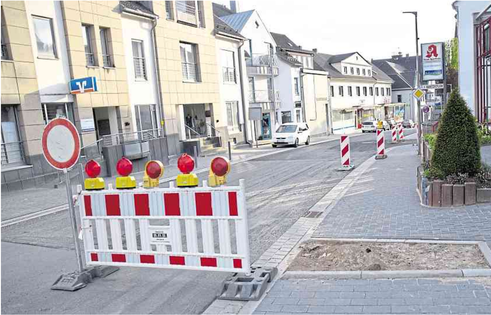
Aufatmen in Hamm: Die Bauarbeiten an der Lindenallee (B 256) neigen sich endlich dem Ende zu. Der Einbau der abschließenden Asphaltdeckschicht ist nun für Montag, 7. Mai, fest von der bauausführenden Firma geplant.
