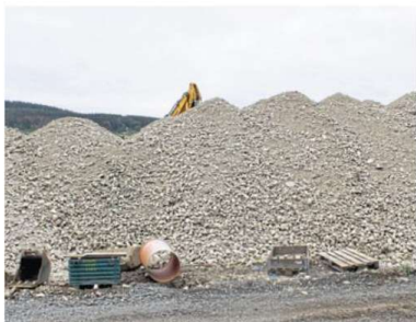
So wird die Großturnhalle schon sehr bald aussehen.
