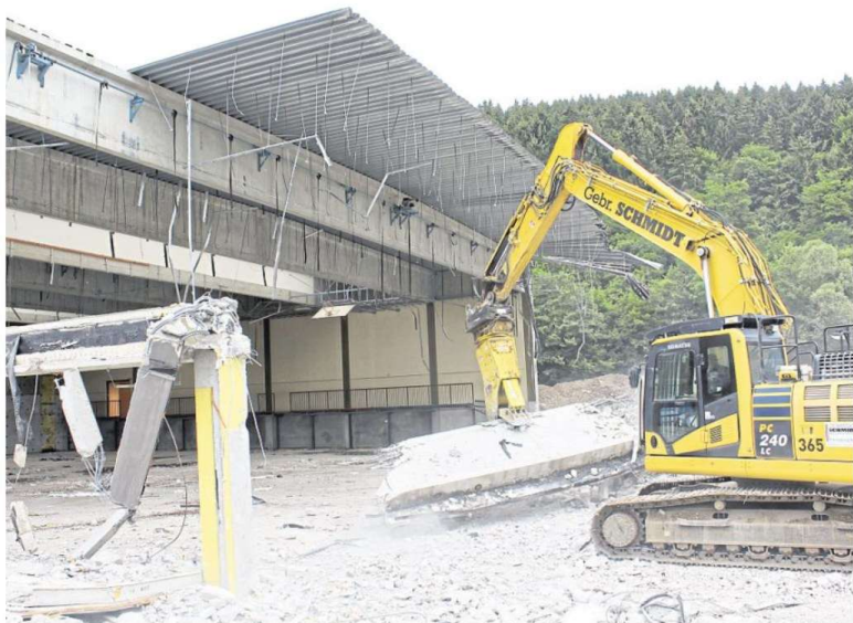
Mit zwei Baggern wird die Turnhalle Stück für Stück auseinandergenommen. Am Mittwoch sollen die Abrissarbeiten beendet sein. Fotos: Johannes Mario Löhr
