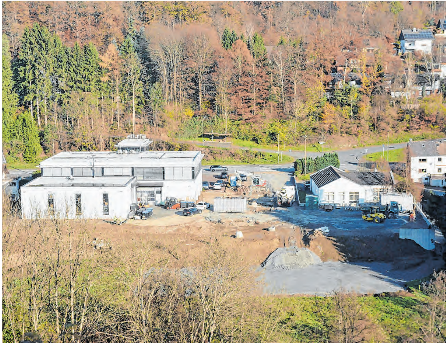
Die Arbeiten zur Erweiterung der Fa. Strunk in Freusburg laufen auf Hochtouren. Nun hat der Stadtrat mit dem Satzungsbeschluss zum Bebauungsplan auch die Rechtsgrundlage für den Bau des Parkplatzes geschaffen.
