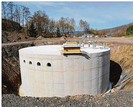
Das Löschwasserbecken oberhalb der geplanten neuen Produktionshalle fasst 300 Kubikmeter Wasser und ist für die Erfüllung der Brandschutzmaßnahmen essenziell. Fotos: Firma
