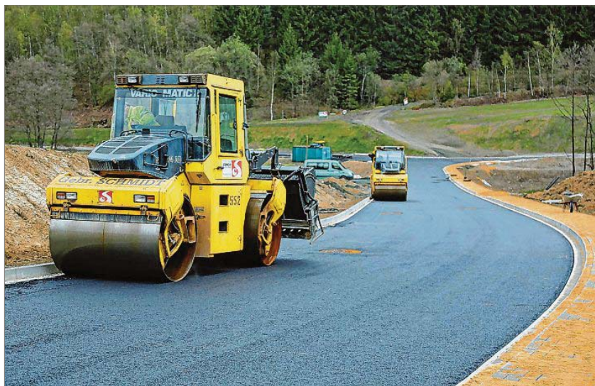
Seit dem 5. April rollen die Walzen durchs Sottersbachtal. Die Straße zur geplanten neuen Produktionshalle nimmt weiter Formen an.
